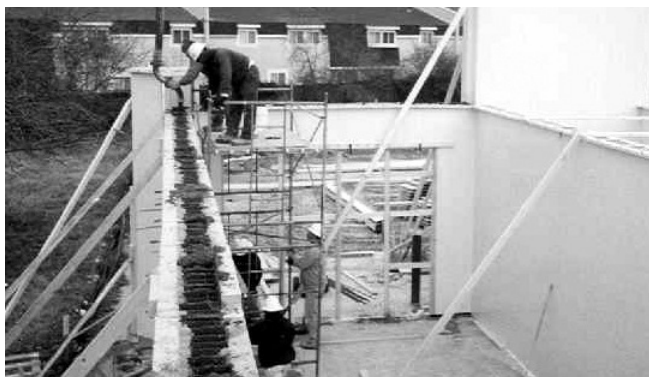
12.1a Concrete Pour in Progress
