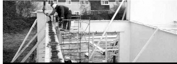
12.1a Concrete Pour in Progress
